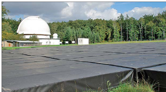
Bild 3: Antennenfeld für das High-Band; unter den Planen befinden sich Styroporboxen mit 16 x 96 Dipolen, im Hintergrund der Container mit den Empfängern, links daneben das Karl-Schwarzschild-Observatorium. Fotos: DL6AKC
