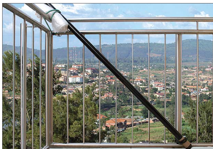
Bild 4: Befestigung des als Antennenträger dienenden Glasfibernastes an einer Balkonbrüstung mittels handelsüblicher Spreizer
